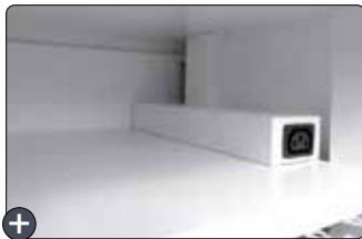
+ Compartiment de rangement avec alimentation électrique pour 1 PC portable
